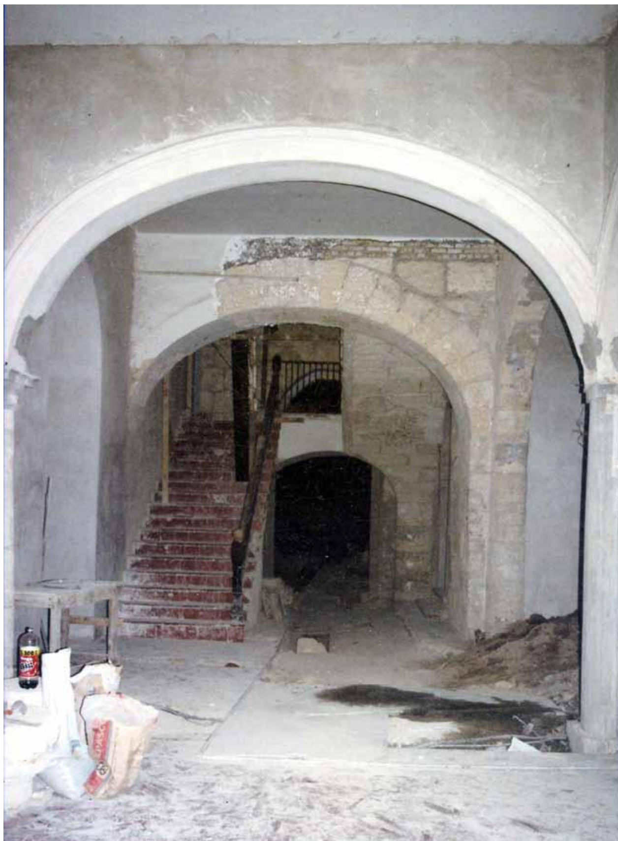
La restauración contemplaba el rescate de los elementos arquitectónicos e históricos del edificio.
