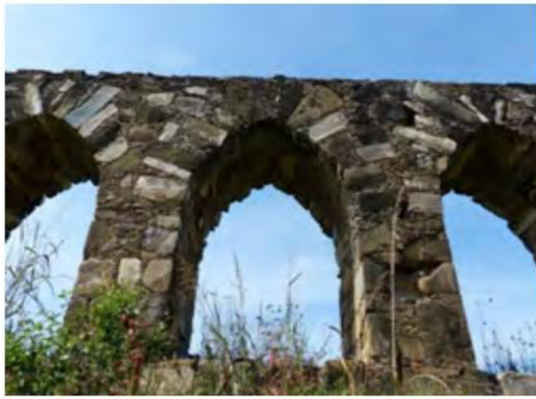
Figura 3. Arcos tipo Tudor del sector arcado del acueducto de la Hacienda de Guadalupe.
