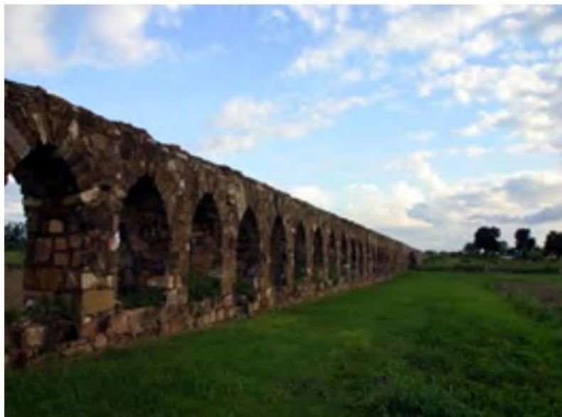
Figura 2. Sector de la arcada del acueducto colonial construido por jesuitas a principios del siglo XVIII.
