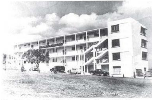
Fig. 1. Instituto de Investigaciones Científicas, UNL. (Matamoros y Circunvalación, hoy José Benítez, Monterrey, N.L.). Planta baja: oficinas y laboratorios. 2º piso: Museo Regional de Historia Natural y aulas de Ciencias Biológicas; 3er piso: Biblioteca Universitaria, ca. 1954.
