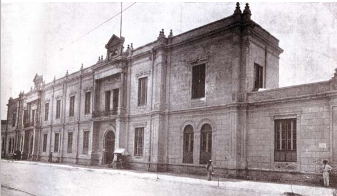
En el edificio de la Normal fue acondicionado un espacio para el establecimiento de la escuela femenil.
