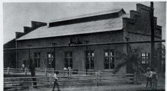
Estación de agua potable de la refinería de la Standard Petroleum Co., en Tampón, Yucatán, también construida de concreto.
