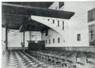
Arco de concreto armado que sostiene las galerías y techo de resistencia para 17 toneladas en la obra del Cine Alcazar que en Tampico, Tams., dirige el Ing. Abraham Gómez.
