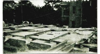
Losas de concreto de «La Victoria» en una construcción regiomontana.
