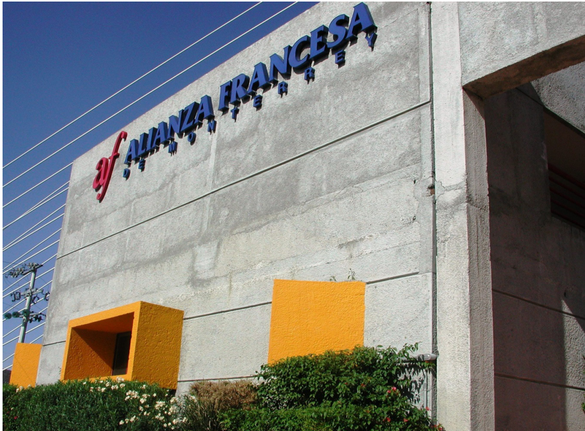
Alianza Francesa de Monterrey / Centro Valle.
