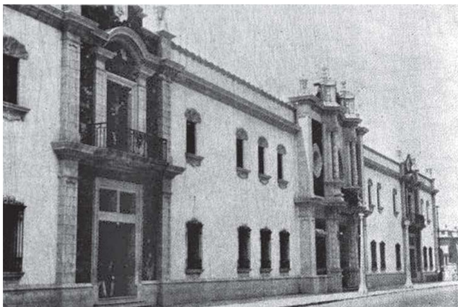
Los trabajos de ampliación tenían como propósito completar el segundo piso del edificio y uniformar el estilo de acuerdo a lo proyectado desde 1933.
