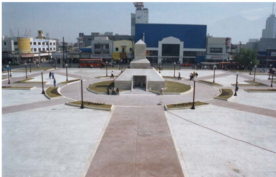
Vista de la plaza hacia el oriente una vez terminados los trabajos de remodelación. Se aprecian los andadores radiales que conducen a la pirámide-obelisco.
