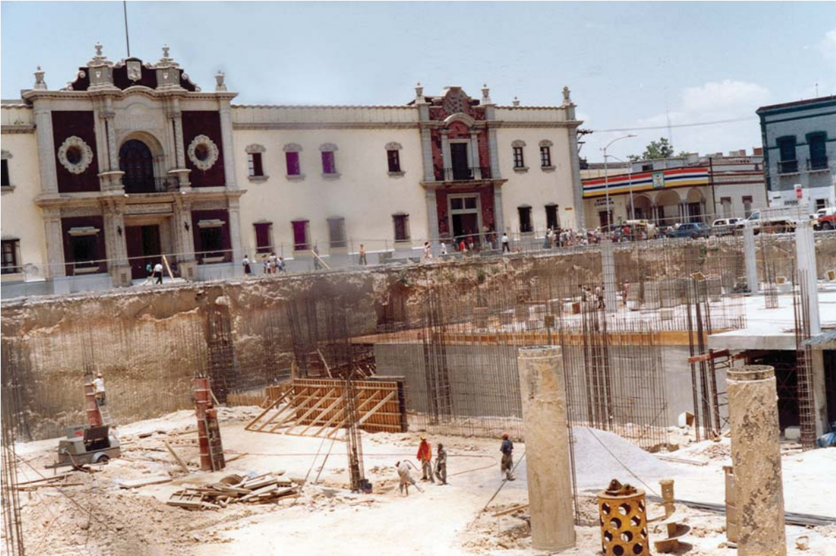
Trabajos de construcción de los dos niveles del estacionamiento subterráneo en el transcurso de 1997.
