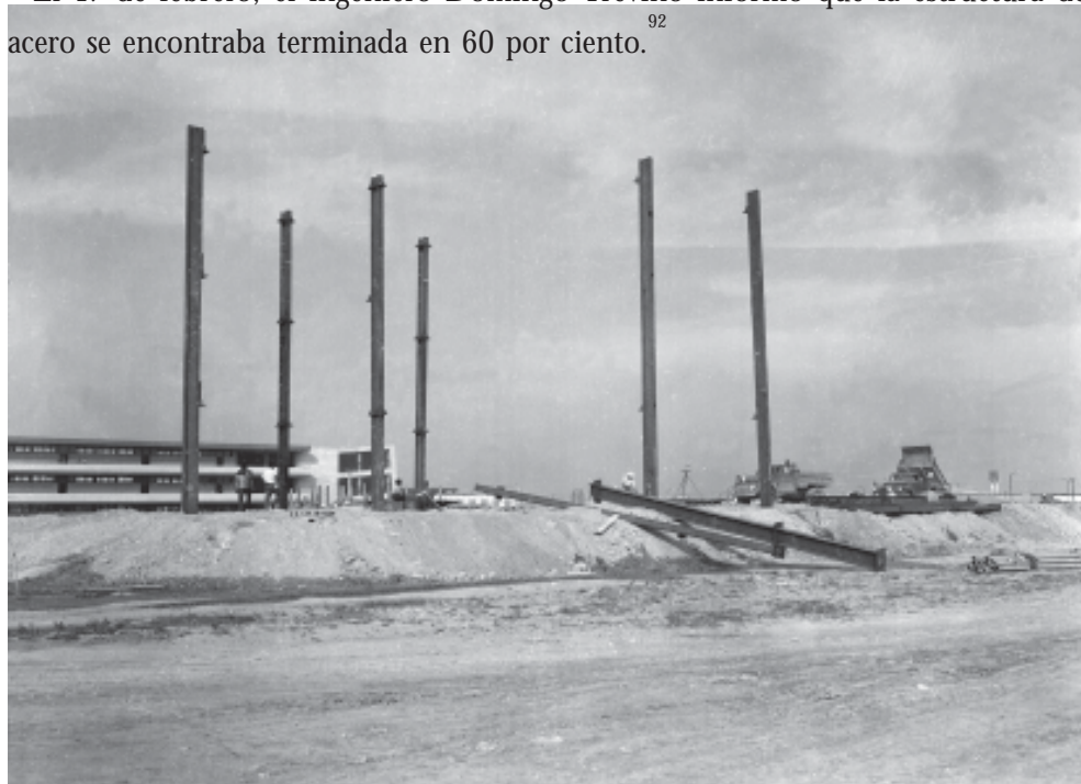
■ Las primeras vigas de la estructura comienzan a levantarse hacia fines de noviembre de 1961 sobre una plataforma de un metro y medio de altura. Al fondo la Facultad de Derecho.
