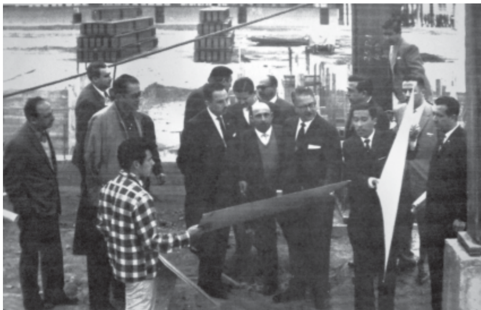
■ El ingeniero Mario I. Ledesma Casillas muestra los planos al gobernador Raúl Rangel Frías durante una visita en el transcurso de los trabajos de cimentación. A su lado aparece Marroquín Toba.
