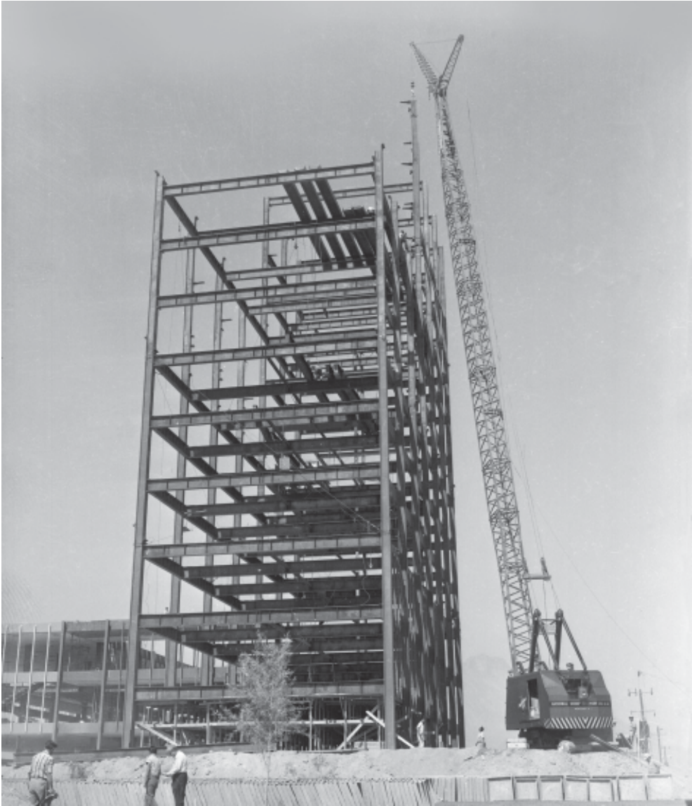
■ Una monumental grúa de la empresa Estructuras de Acero alza una de las vigas perimetrales de la cara norte del edificio que en ese momento tenía levantada su armazón hasta el noveno piso, incluyendo el área porticada.
